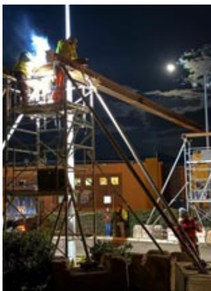
16 – Travaux téléporté : installation d'un portique de sécurité au rond-point du centre commercial de la rocade
