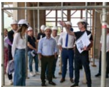
28 – Visite de chantier du pôle multimodal de Mezzana
