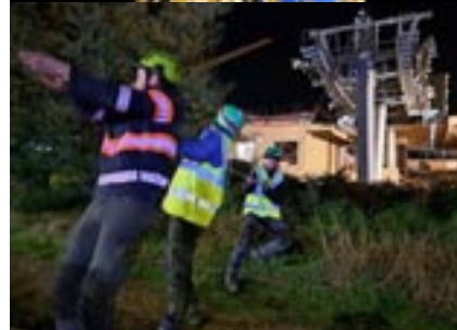
29 – Travaux téléporté : préparation du déroulage du câble ! Étape importante : mise en place d'une cordeline entre les gares N°3 du Stiletto et N°4 de Mezzavia
